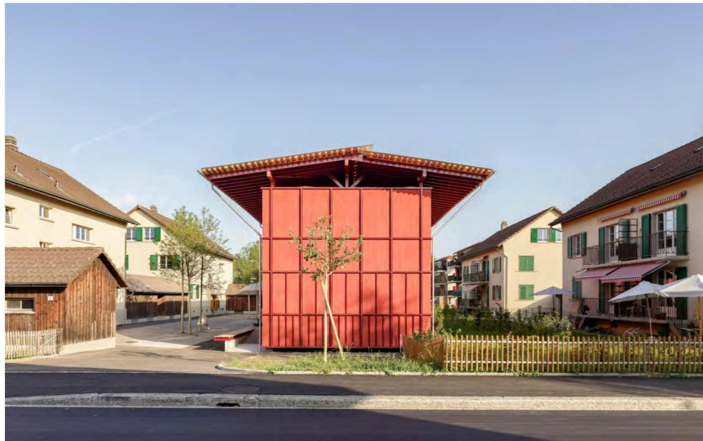
Beispiel ein Gebäude der Pappelhöfe in Langenthal
