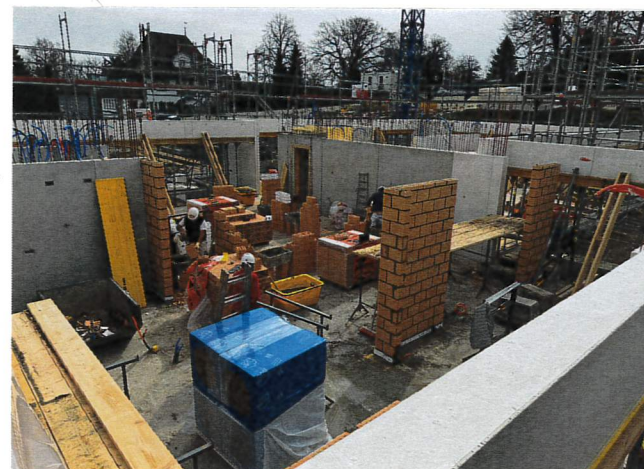
EG WÄNDE BETONIEREN & MAUERH
