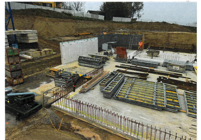
UG BODEN & WÄNDE ARMIEREN & BETONIEREN
