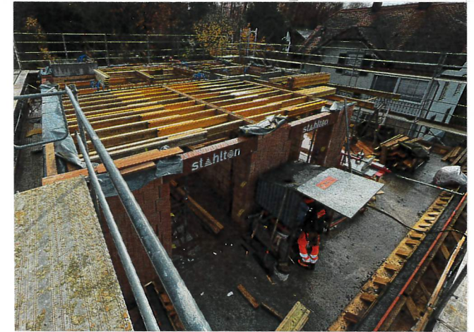
OG WÄNDE BETONIEREN & ARMIEREN + DECKE BETONIEREN
