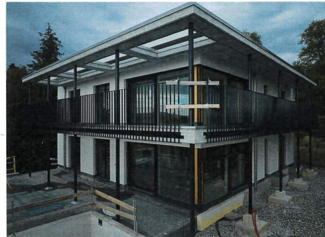
VERPUTZARBEITEN & WEITERE FERTIG- STELLUNGEN
