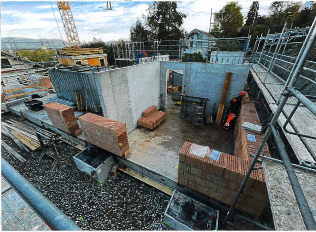
EG WÄNDE BETONIEREN & MAUERN
