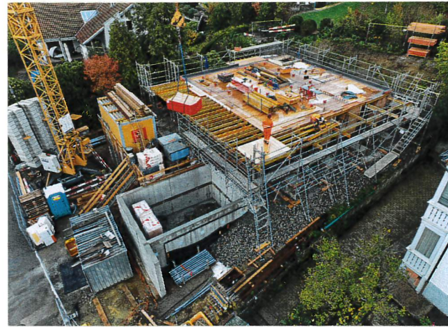
DECKE ÜBER EG ARMIEREN, LEITUNGEN EINLEGEN & BETONIEREN
