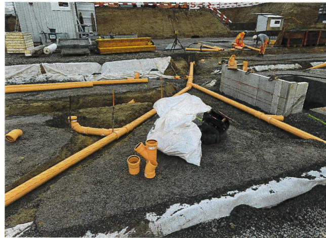
MAGERBETON & KANALISATION EINLEGEN
