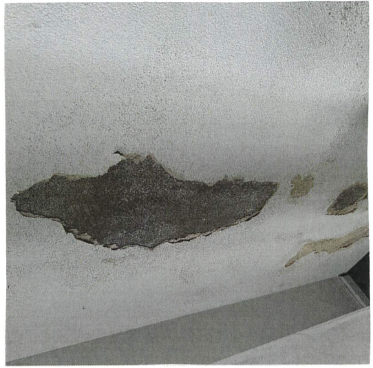
BILDER DER FEUCHTESCHÄDEN
